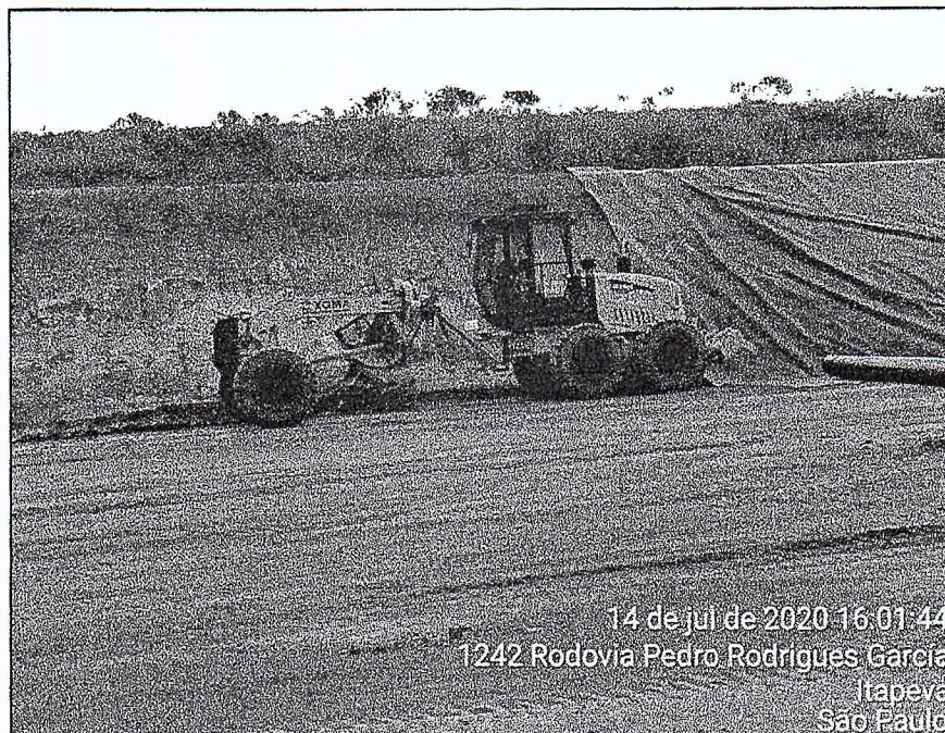
Figura 14: Aterro municipal em fase final de construção.
