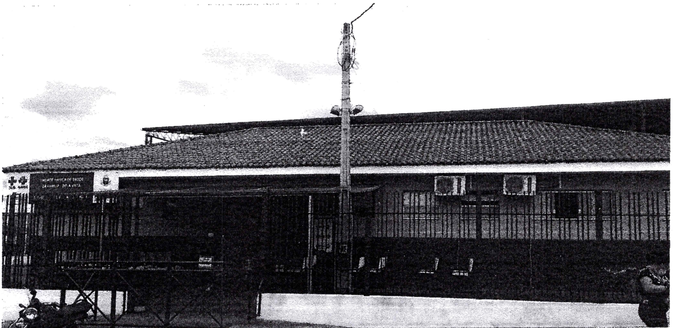
FOTO 04 – UBS DO JARDIM BELA VISTA NA RUA JOÃO PERRETTI.
